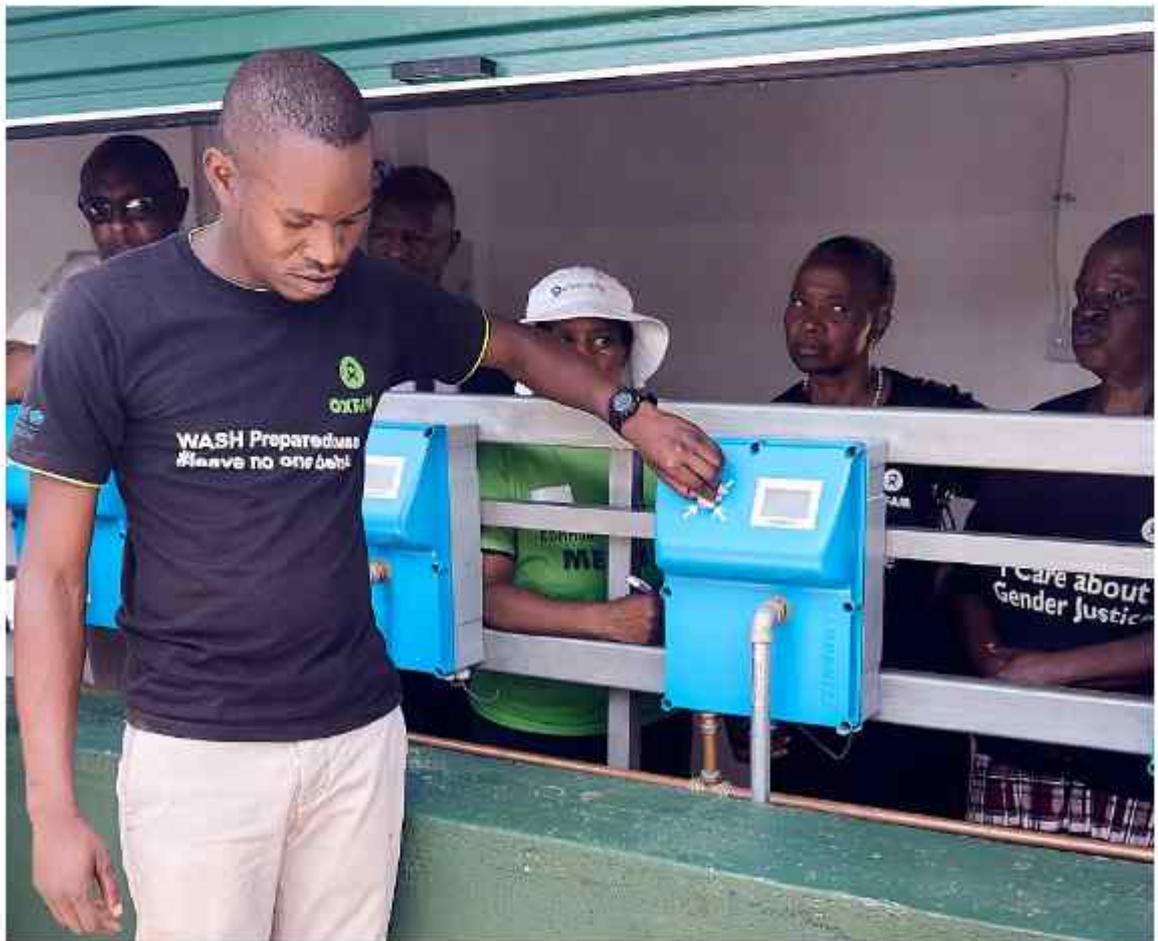
Photo : Oxfam | Le personnel d'Oxfam vérifie un distributeur d'eau communautaire prépayé récemment installé dans le cadre du programme WASH axé sur les marchés (Zimbabwe, 2018).
